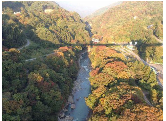
▲正面のV字谷に、向こうの景色が見えなくなる程のダム堤がそびえ立つ。ハッ場大橋の巨大な陰が錦の河畔林に影を落としている。
