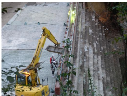
▲「仮締切工事で建設中の小ダム」（10/15撮影）
