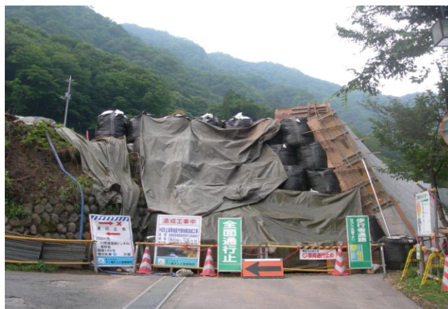
▲川原湯温泉街の坂を上がって川原湯神社を過ぎたあたり。付け替え鉄道工事のため、豊田乳業さんへの道がふさがれている。
