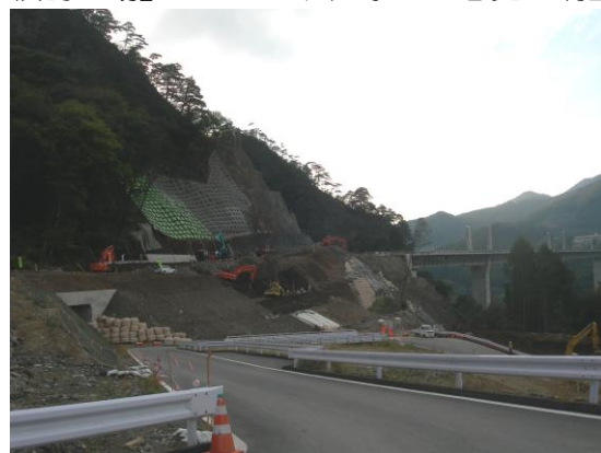
▲有名な湖面2号橋(正式名称:不動大橋)の下流側(川原湯地区)。橋は完成したが、川原湯との間の付け替え県道はまだ工事中。
