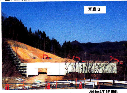
本体左岸上部掘削造成工事(約10万 \text{m}^3 の掘削)(~2014年10月末)
