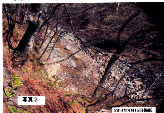
仮排水トンネル呑口直下の吾妻川(枯渇している)
