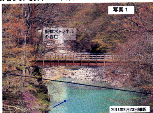
仮締切工事(上流)(29mの小ダムをつくるために石垣で吾妻川を締め切っている。)(~2014年7月末)
