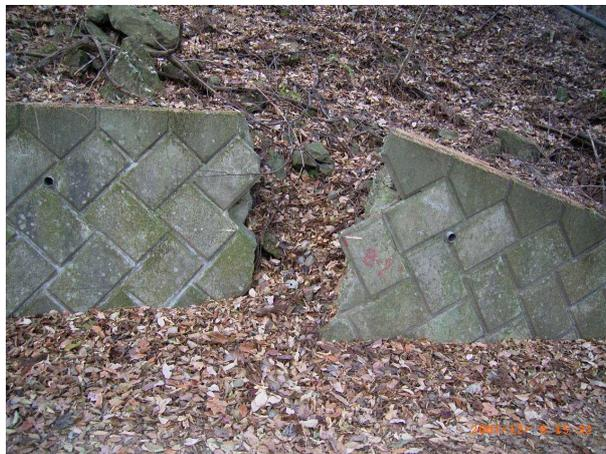
写真 - 3 写真 - 2のような尾根の先端の道路際に見られる間知ブロック擁壁の破壊。筆者撮影。
