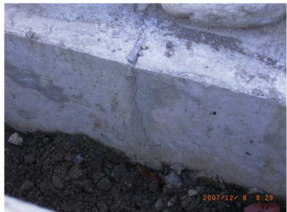
写真 - 1 上湯原の宅地造成地で見られる石積み擁壁基部のクラック（筆者撮影）
