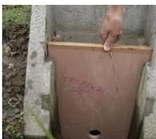
単。これまでの排水溝に小さな穴のあいた調整板を取り付けるだけだ。これで田んぼに降った雨を貯留し、用水路の氾濫を防ぎ、周辺の耕作地や住宅地を守り、河川への流入量をコントロールして治水効果を上げる。畦の高さを上げればさらに効果は上がる。現在、新潟県、兵庫県、北海道、山形県など全国に広まりつつある。
