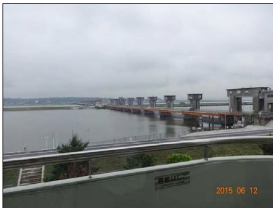
常陸川水門 写真：利根川流域市民委員会
